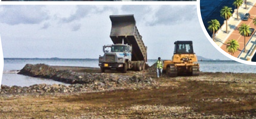
Construcción de espigón para desembarque de roca en Vacamonte.
