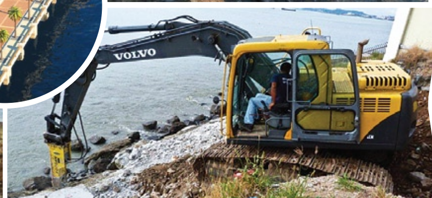
Se inicia la construcción del puente de acceso.
